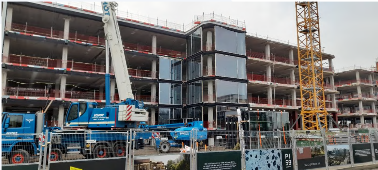
afbeelding 1 montage gevelelementen PI59
