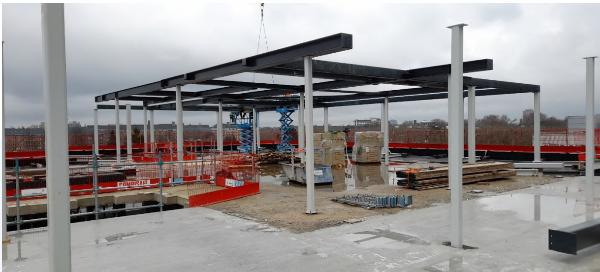
afbeelding 2 montage dakopbouw
