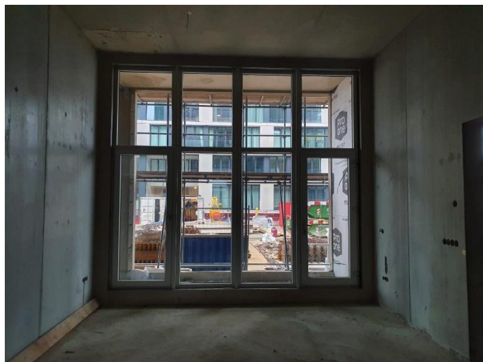
Foto boven: appartement van binnenuit gezien, met zicht op 'De Syp'.
