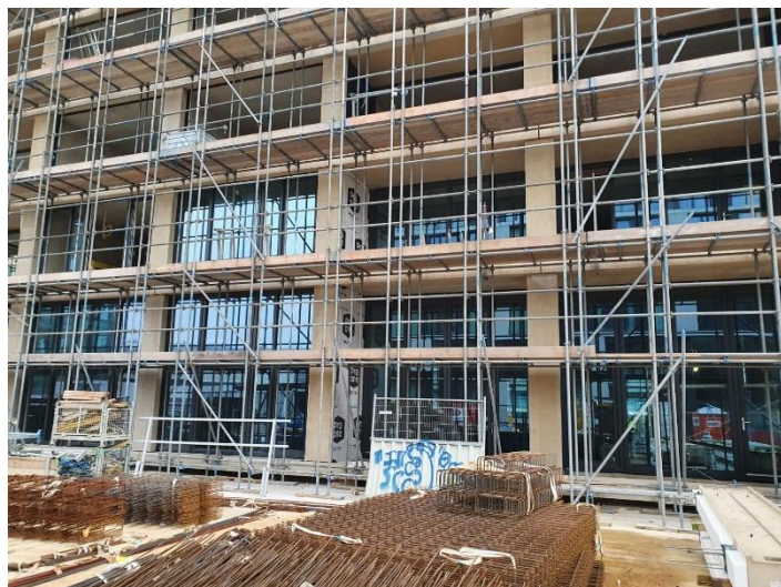
Foto boven: Kozijnen worden geplaatst in Fase 3C.
