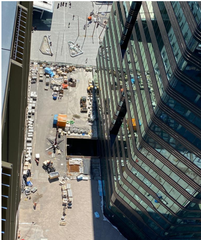
Foto boven: Werkzaamheden aan het Forum plein zijn in volle gang.
