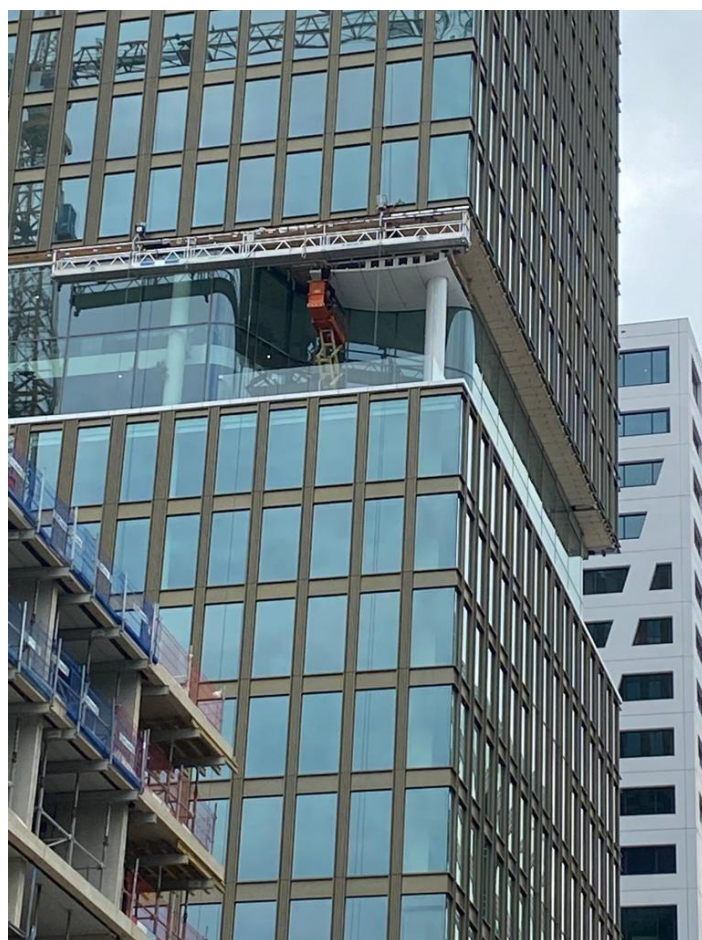
Foto boven & onder: Het golvende plafond aan de buitenzijde van Central Park (12 e etage) wordt geplaatst.
