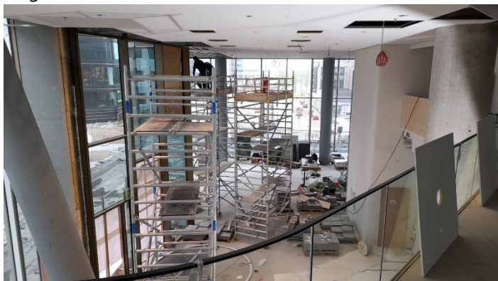
Foto boven: Werkzaamheden op de begane grond van Central Park.
