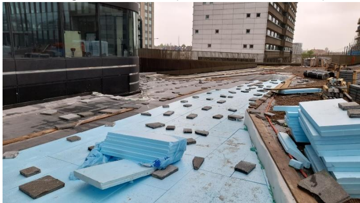
Bovenstaande foto: de werkzaamheden aan het Forum plein zijn in volle gang.
