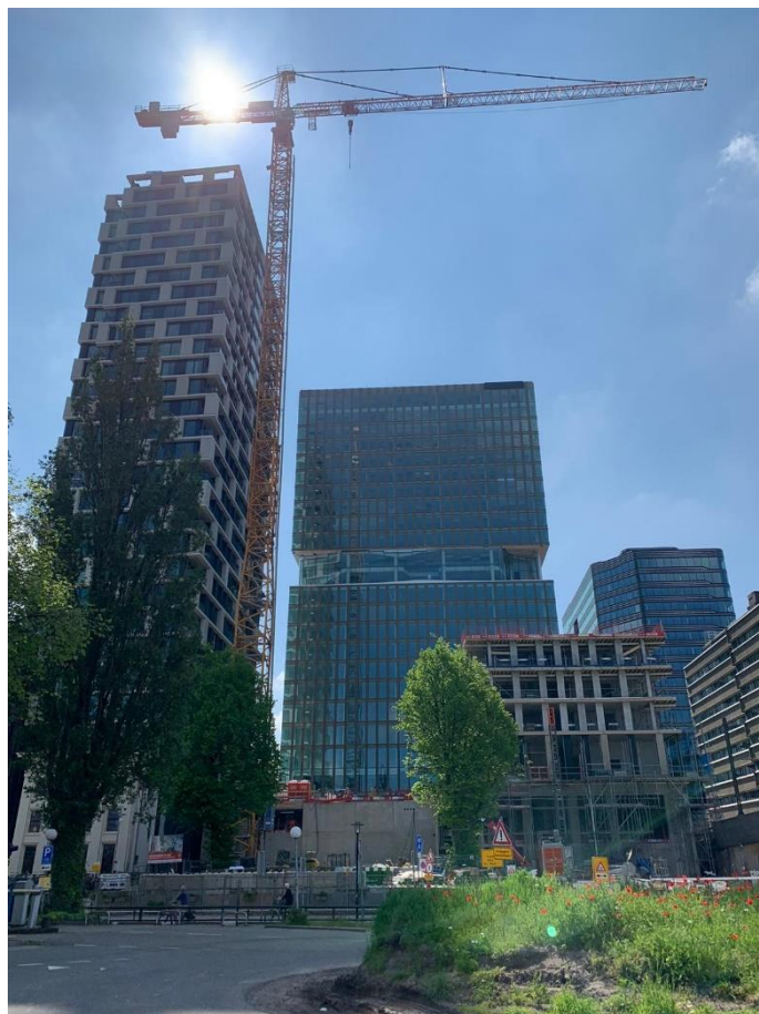
Foto boven: zicht op de bouwplaats gezien vanaf Lombokplein.
