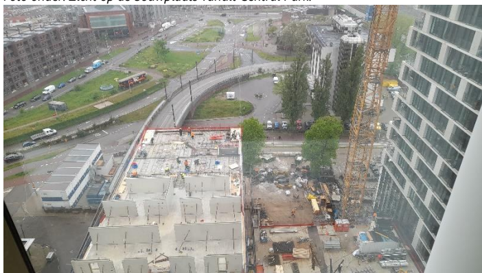
Foto onder: Zicht op de bouwplaats vanuit Central Park.
