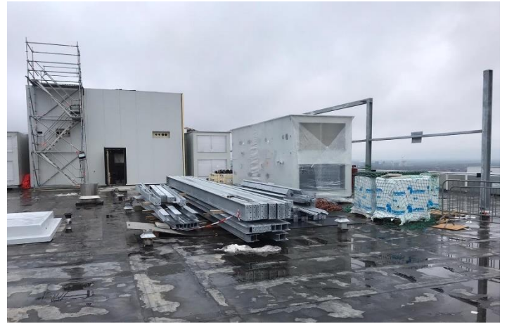
Foto boven: De locatie op het dak waar de torenkraan stond is dicht inmiddels.
