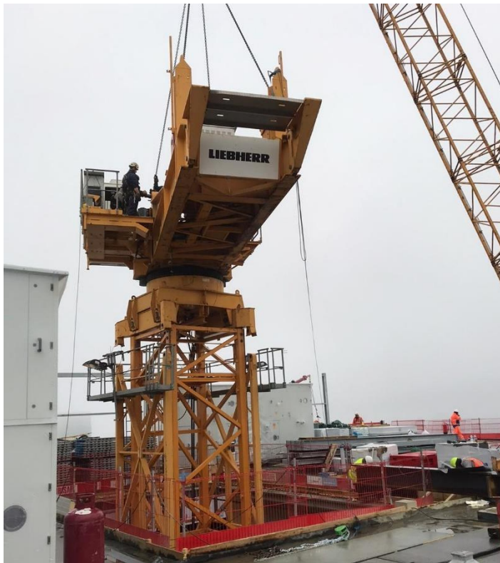
Foto boven & onder: De torenkraan wordt in delen afgebroken en afgevoerd.
