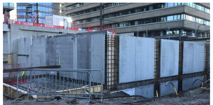
Foto 1 t/m 3: Zicht op een deel van de parkeergarage, met op de achtergrond o.a. Central Park, het WTC en hotel.
