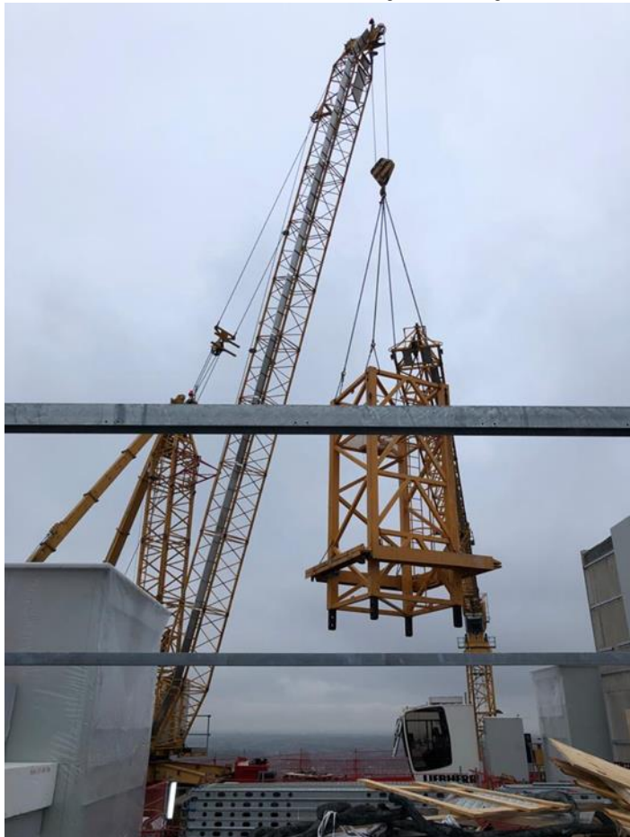
Foto boven & onder: De torenkraan wordt in delen afgebroken en afgevoerd.
