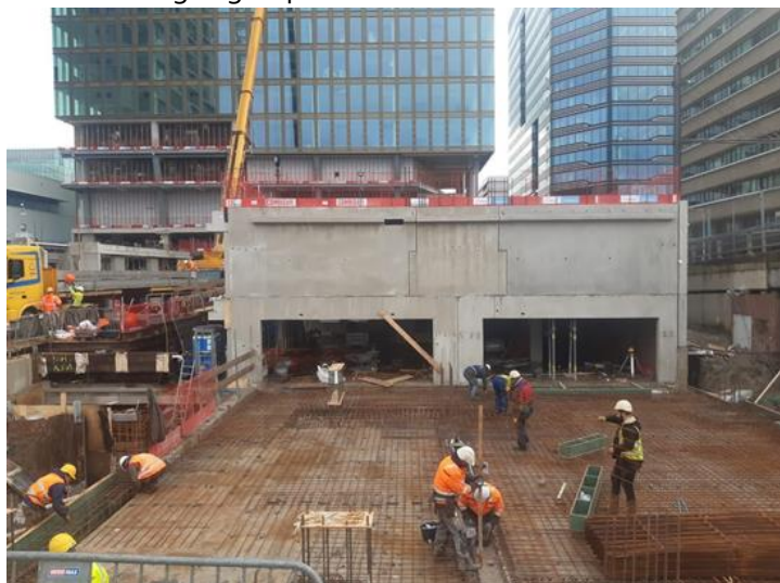
Foto 1: Zicht op betonvlecht werkzaamheden ten behoeve van de parkeergarage.
