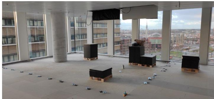
Foto boven: Het leggen van de computervloer op een verdieping.
