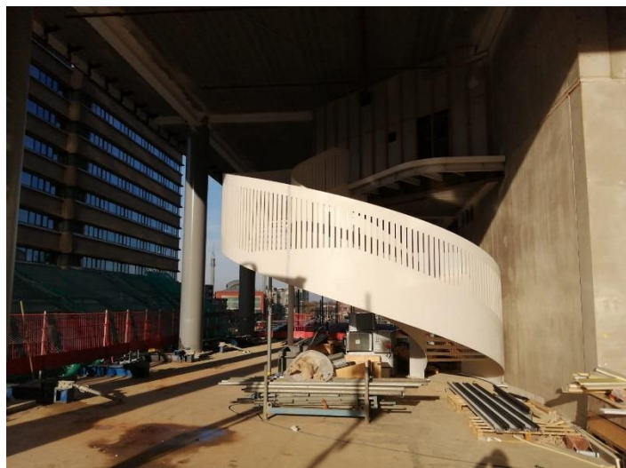
Foto 8: De wenteltrap op de begane grond is geplaatst.
