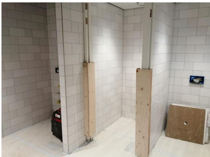
Foto 7: Toiletten zijn in de maak.
