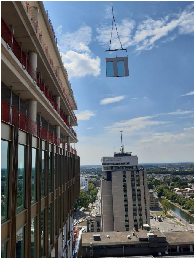
Foto 9: Een gevelement wordt naar boven gehesen op de bouwplaats.
