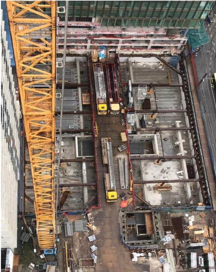
Foto 11: Zicht op de bouwplaats vanuit de kraan naast woontoren 'De Syp'. Op vrachtwagens liggen kanaalplaten waar de vloeren mee gelegd worden.
