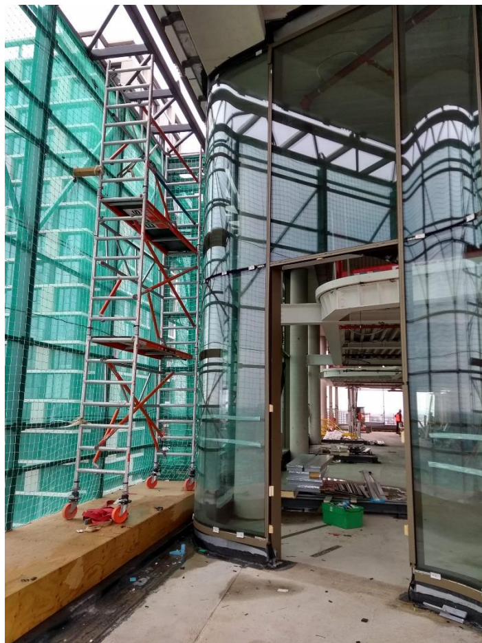
Foto 4: Het gebogen glas op de 11 e & 12 e verdieping, met een sneak peak naar binnen.
