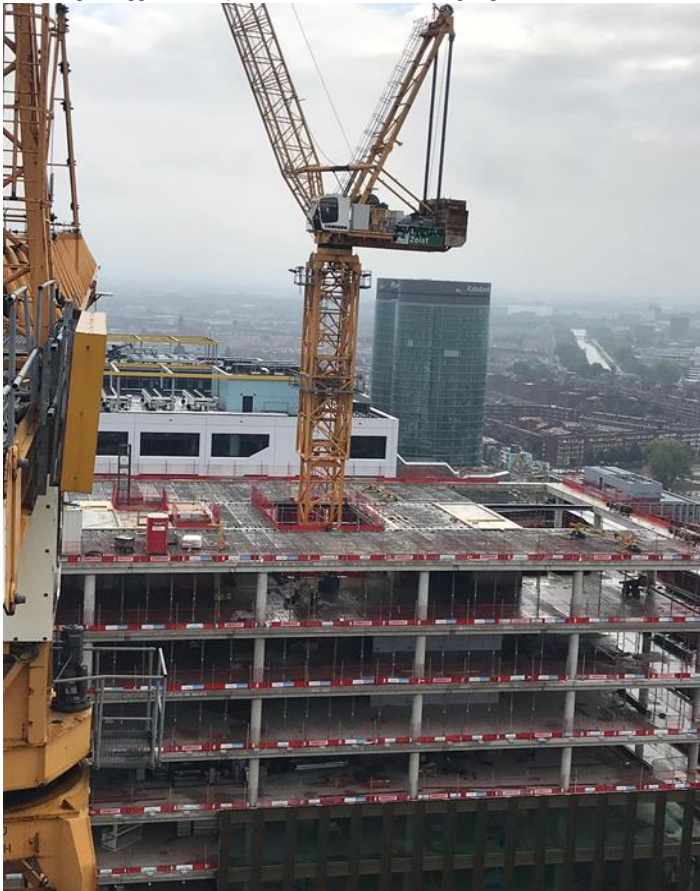
Foto 12: Zicht op bovenste bouwlaag waar de kanaalplaten goed te zien zijn.
