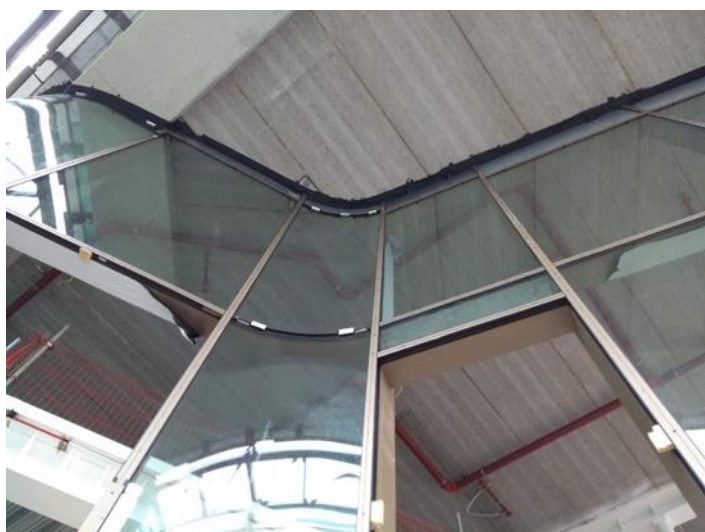
Foto 3 : Het gebogen glas op de 11 e & 12 e verdieping, naar boven kijkend.
