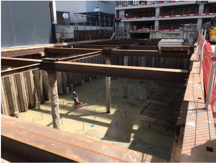
Foto 3: Het schoon maken van de leeggepompte bouwkuip.
