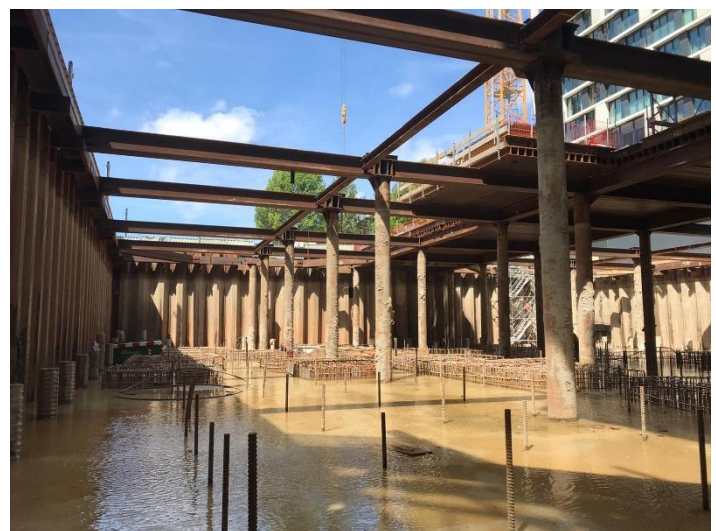
Foto 2: De leeggepompte kuip, klaar voor de schoonmaak.
