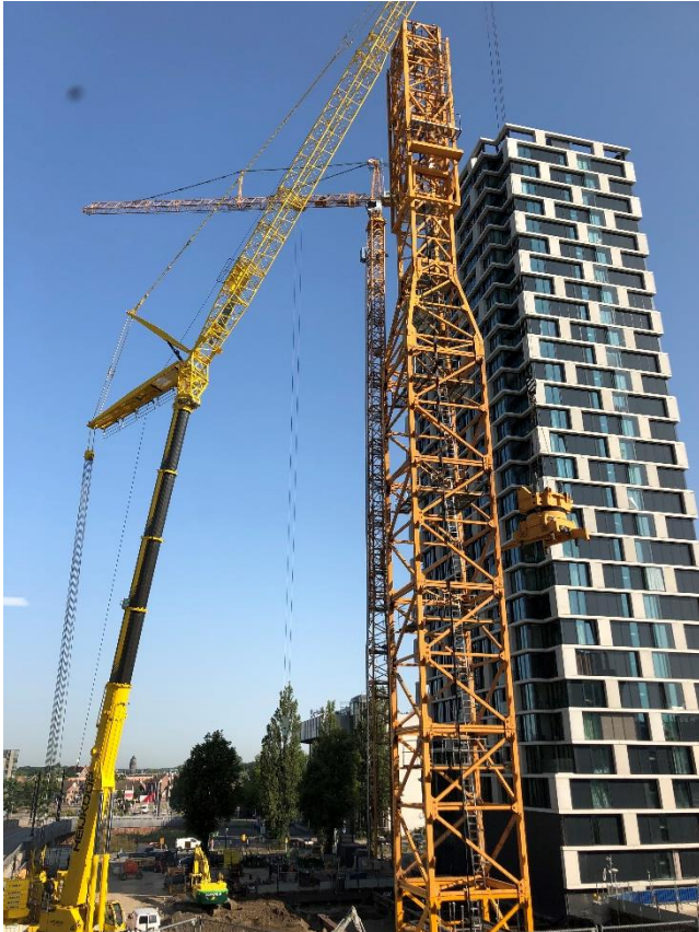
Afbeelding 3: Het opbouwen van de torenkraan.
