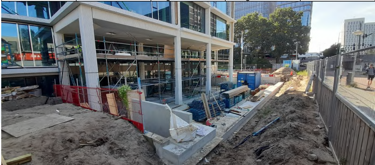
afbeelding 7 horeca terras bouwplaats
