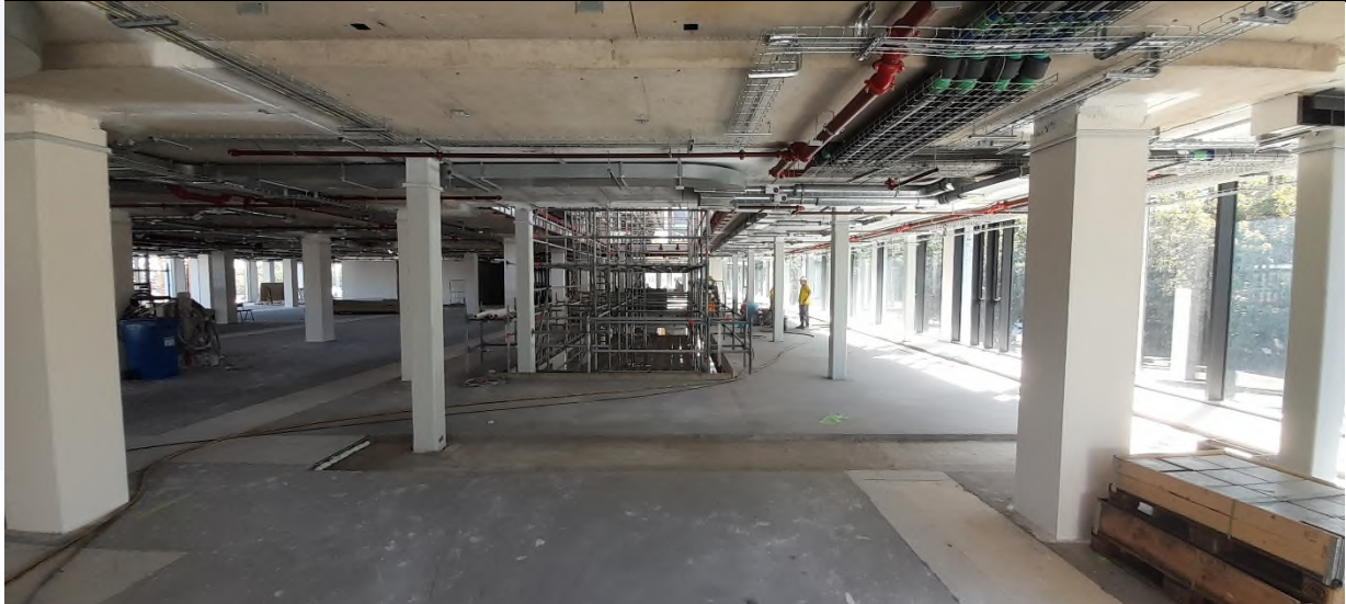
afbeelding 3 zandcement dekvloer
