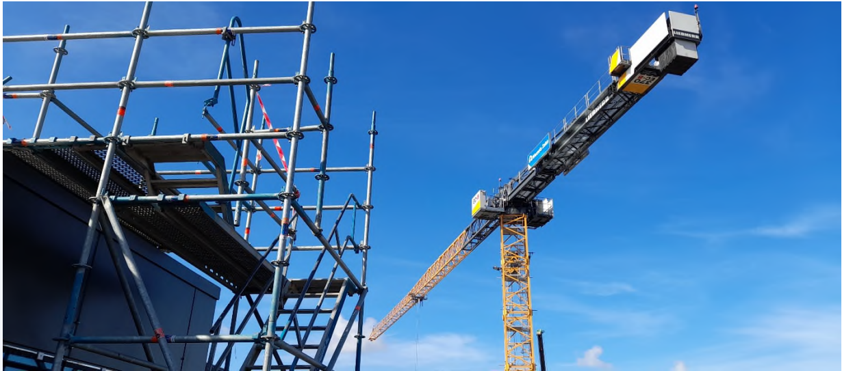
afbeelding 6 einde werkzaamheden torenkraan
